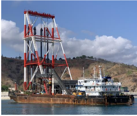
图 22 海上底部出料振冲施工配套设备
