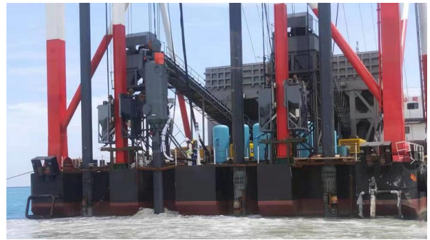
图 25 海上底部出料振冲施工场景
