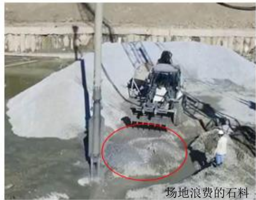
图 16 传统振冲法施工现场 Fig. 16 Construction site of traditional vibroflotation
