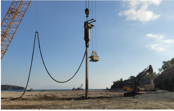
图 10 底部出料振冲器系统外观 Fig. 10 Bottom feed vibration system
