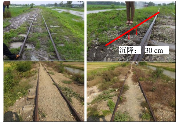
(a) 施工前路基
