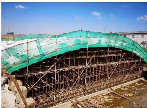
(d) 堆载预压模拟施工荷载
