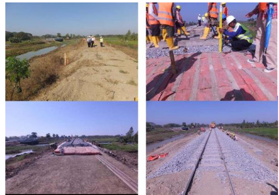
(b) 地固件施工过程
