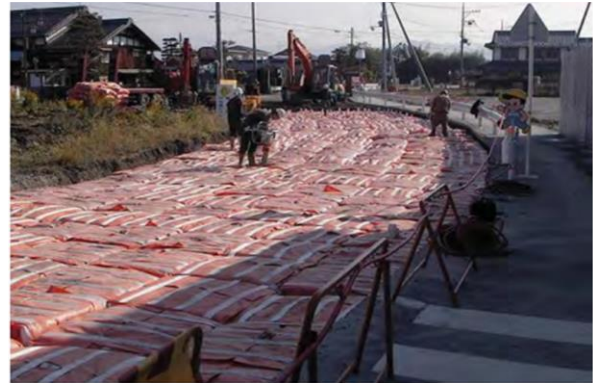
(b) 施工现场
