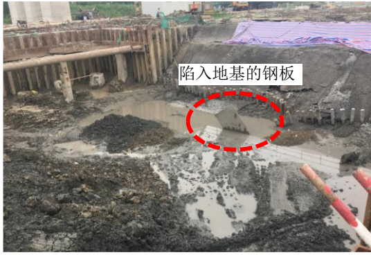
(a) 施工前场地
