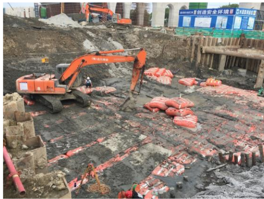
(b) 地固件施工
