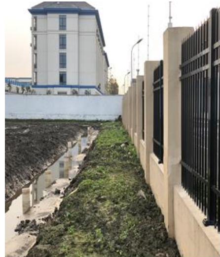
图4 3号、5号、7号楼应力释放孔和防挤沟
