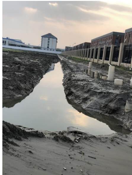
图5 1号楼应力释放孔和防挤沟
