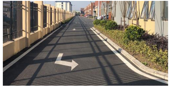
(a) 2019 年 12 月 31 日拍摄无可见裂缝
