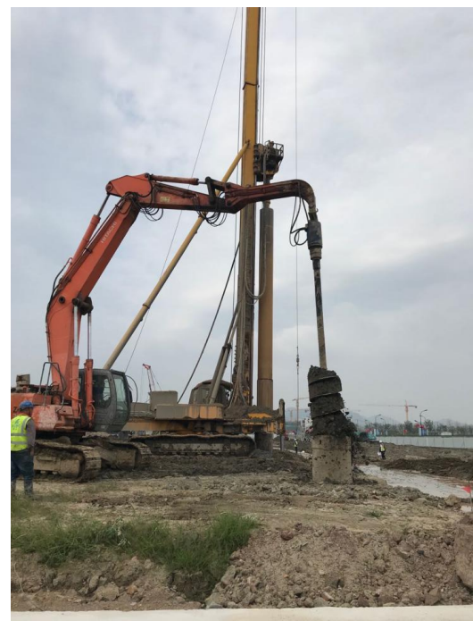
图 3 气动潜孔锤和螺旋钻机
