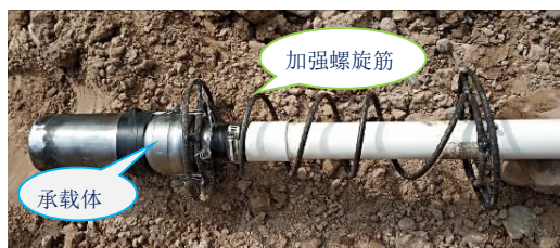
图11 可回收锚杆安装完成图
