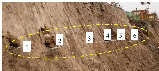
图9 试验现场 Fig. 9 Test site
