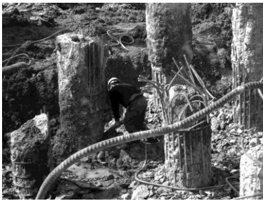
图 2 工程桩桩头
