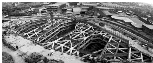
图 1 基坑工程钢筋混凝土支撑
