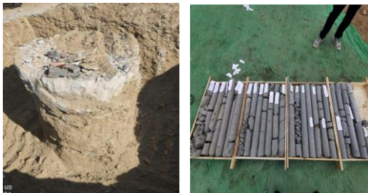
图8 DJP 水泥土桩开挖及取芯效果
