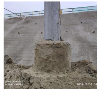
图11 DJP 复合管桩开挖效果
