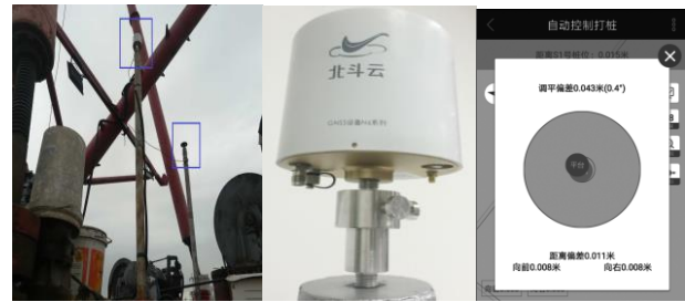
图4 旋扩钻机就位定点
