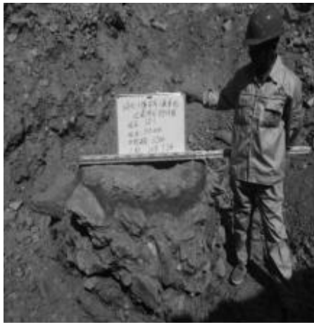
图 12 水泥土桩成桩效果
