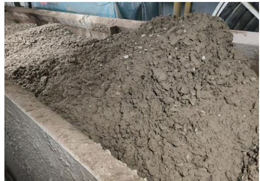
图1 盾构机出渣情况
