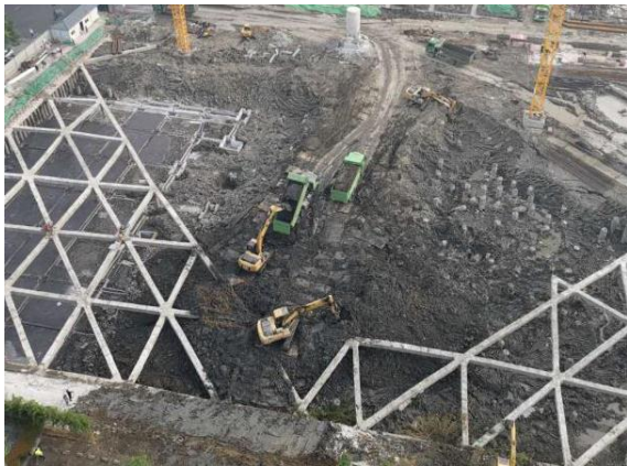
图 5 基坑滑移范围土方回填
