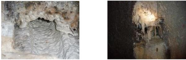
(a) 排水孔析钙堵塞失效 (b) 监测仪器析钙裹塞失灵
