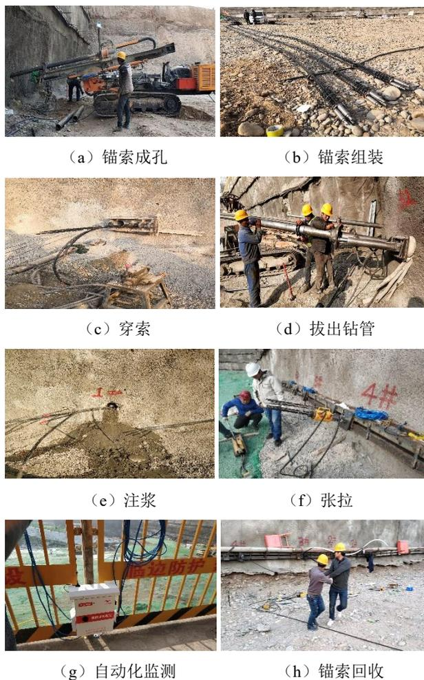
图3 可回收锚索试验流程
