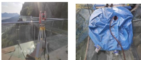
图 10 悬臂梁现场静载荷试验
