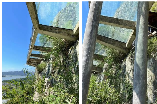
图5 悬挑梁根部与基岩连接
