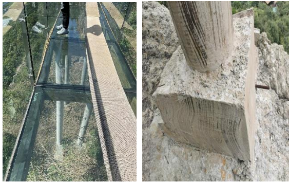
图3 立柱及立柱基础图
