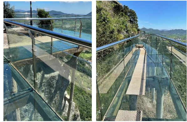
图6 栈道外侧栏杆实景
