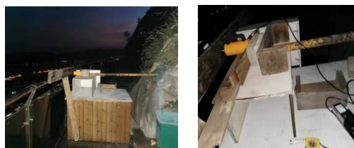
图 11 栏杆水平推力现场试验
