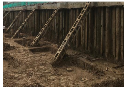
图 6 斜向支撑桩照片
