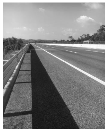
图11 右幅桥头过渡路纵坡照片
