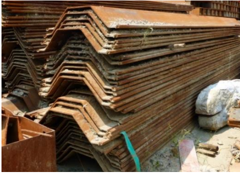
图 11 回收分解后的帽型钢板桩
