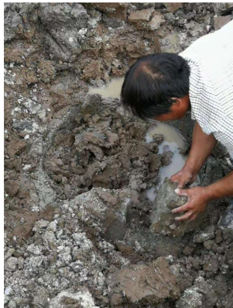
图 7 PCC 桩施工现场图 (成桩 2 d 后)
