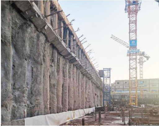
图5 现场基坑开挖效果
