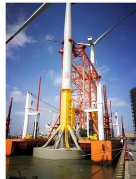
图 1 海上风电复合桶基础
