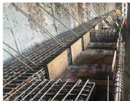
图 6 外圈梁施工 Fig. 6 Construction of outer ring beam
