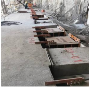
图7 预加力系统安装
