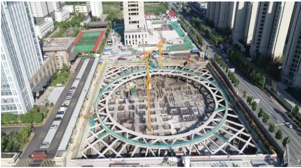
图 10 基坑支护结构完成全貌
