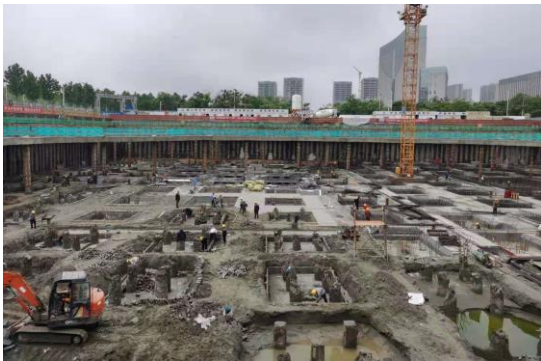
图 7 基坑开挖施工实景
