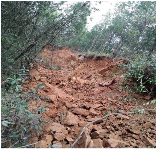
图2 滑坡后缘裂缝
