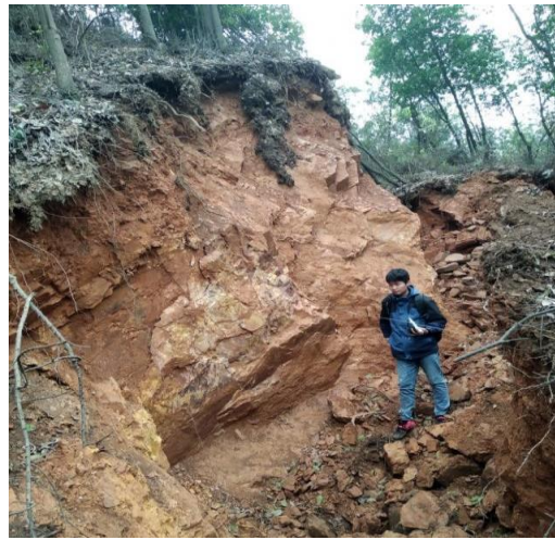
图3 滑坡右翼开裂下错
