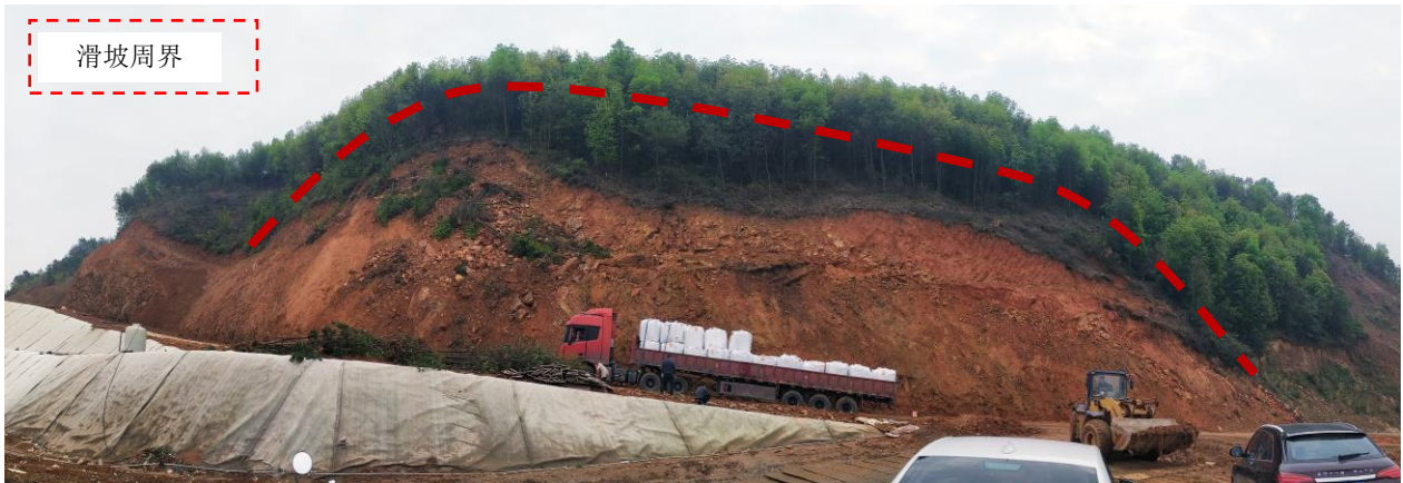
图6 滑坡全貌及前缘(部分滑体堆积于人工切坡台阶上)
