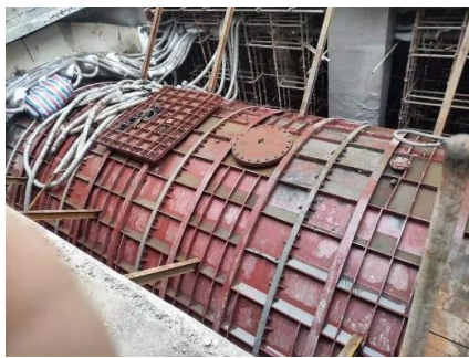
图 2 盾构接收钢套筒
