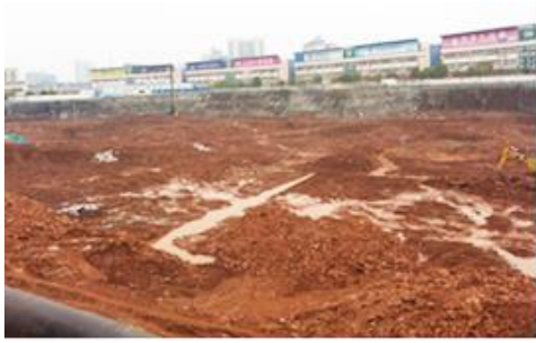
图9 基坑开挖现场
