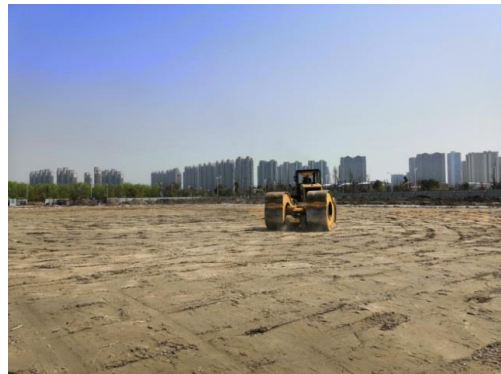
图 3 冲击碾压施工图
