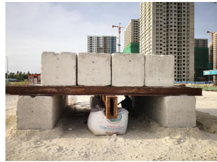
图 4 现场吹填珊瑚砂地基平板载荷试验
