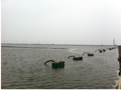
图1 真空联合水载预压现场
