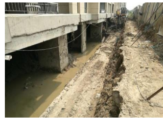
图 8 南侧土方开挖现场图
