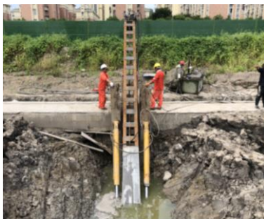
图1 强制搅拌斜向支撑桩正向图
