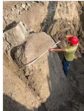
图3 强制搅拌体以及扩大底部开挖现场图
