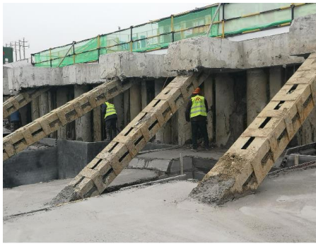
图13 开挖完成实景照片
