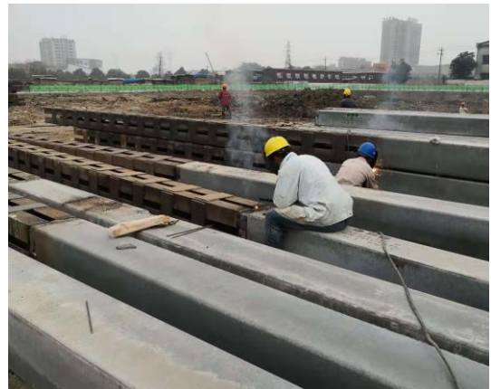
图 7 钢格构与预制方桩端部焊接
