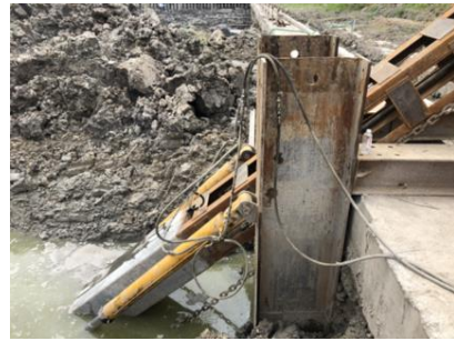
图2 强制搅拌斜向支撑桩侧向图
