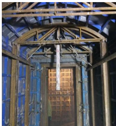
图4 钢模板施工
