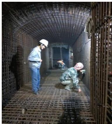
图3 钢筋绑扎施工
