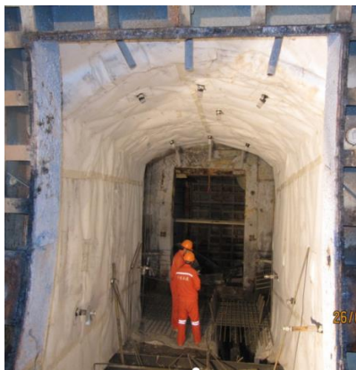
图2 防水层施工
