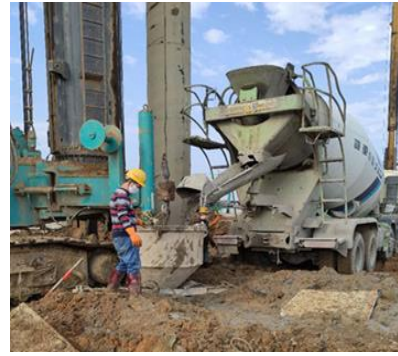
图 6 灌注混凝土
