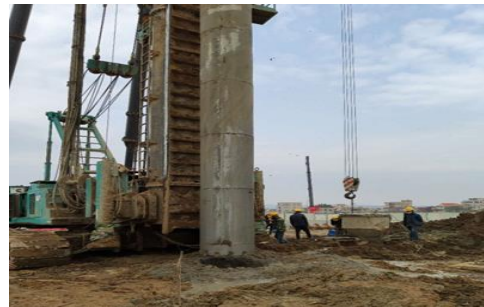
图 7 拔出全套管
