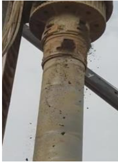
图2 全套管打入图 Fig. 2 Full casing driving
