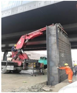
图 13 低净空连续墙钢筋笼拼接入槽
