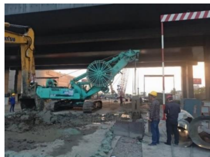
图 12 低净空连续墙成槽
