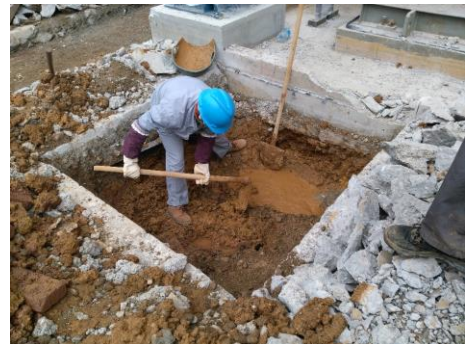
图7 建筑物基础加固
