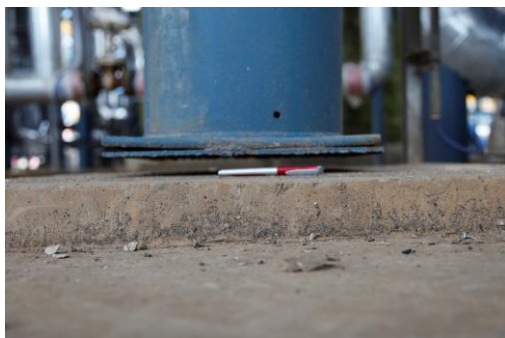
图3 钢结构与基础分离
