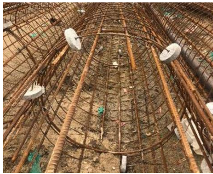
图 10 钢筋笼水泥保护块
