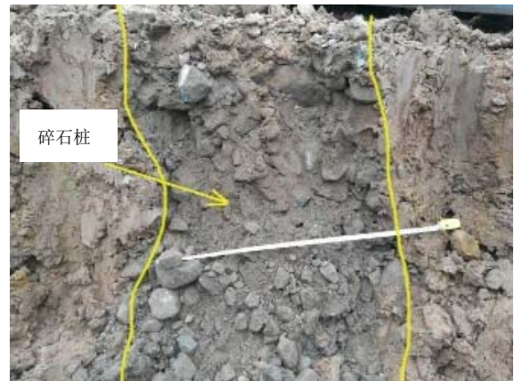
图1 振冲碎石桩纵剖面
