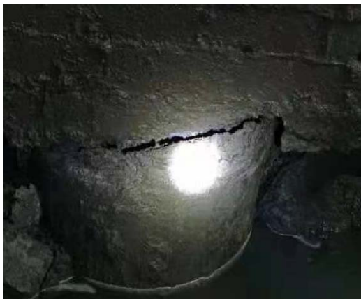
图3 桩基裂缝
