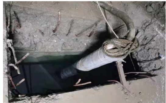
图 9 现场降水井 Fig. 9 On site dewatering well
