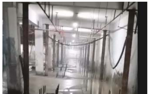
图 6 钢管临时支撑
