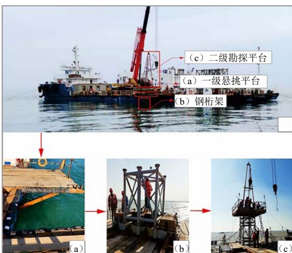
图 4 水域傍船组合式钢桁架作业平台
