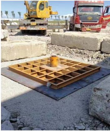
图5 静载试验现场照片
