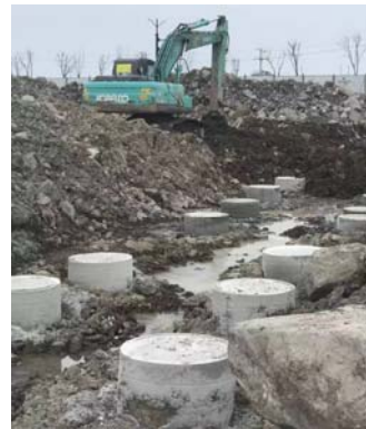
图 4 素混凝土封口完成后的照片
