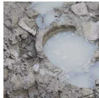
图 3 超薄型 PCC 桩现场开挖照片
