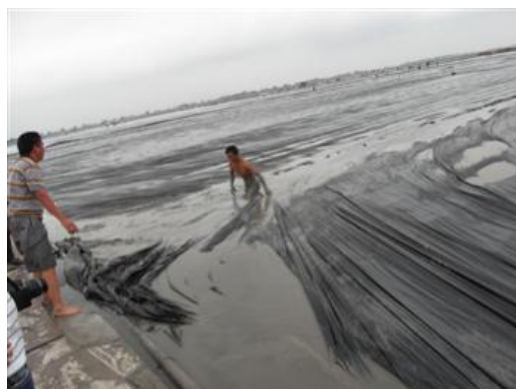
图5 铺真空膜并压膜密封
