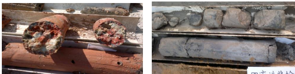
图 6 双重管双液注浆检查孔局部特写照片
