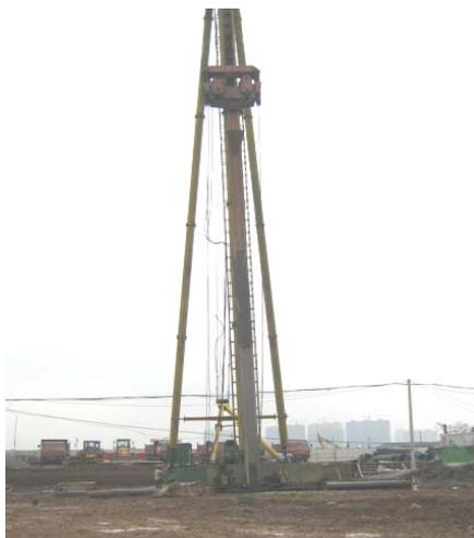
图 12 现浇 X 形桩复合地基加固江山大街路基施工现场
