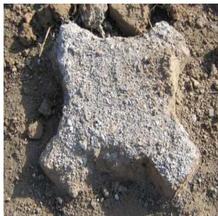
图 5 现浇 X形桩桩头
