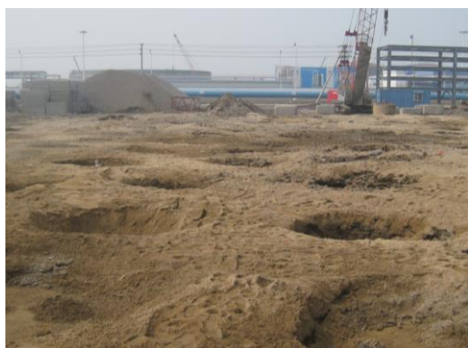
(a) 强夯区施工现场-1
