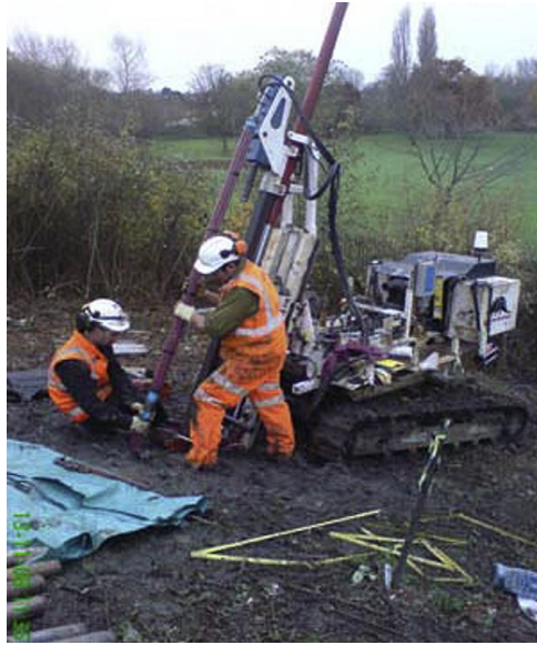
图 10 采用 P45 钻机安装 EKG 电极
