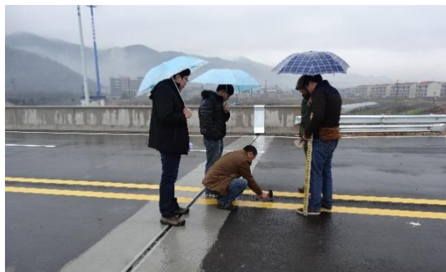
图 11 工作人员安装布置监测点
