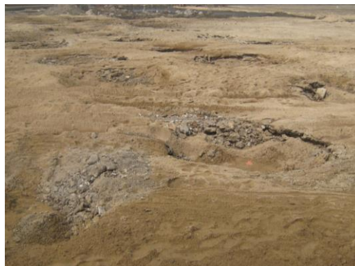
(b) 强夯区施工现场-2
