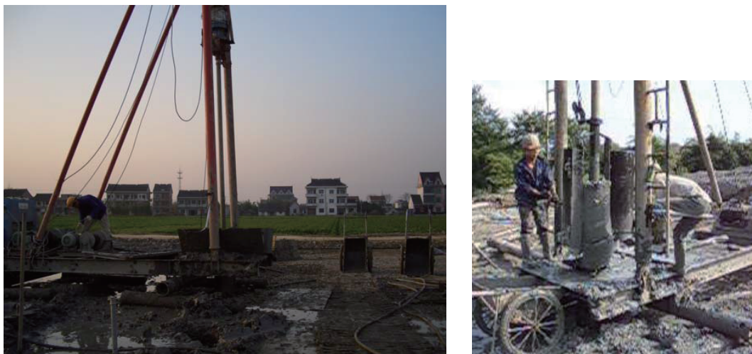
图1 浆固散体材料桩施工机械实物图
