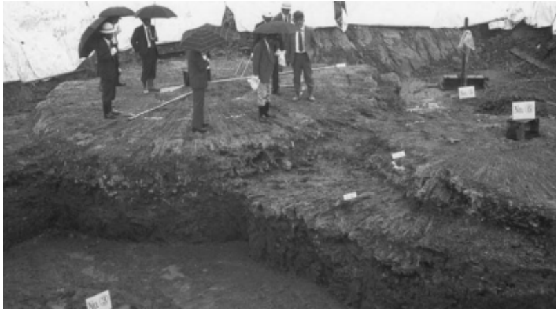
图3 Super Jet 工法形成的旋喷桩 [19]
