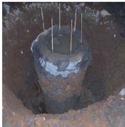
图3 浆固散体材料桩桩头开挖实物图
