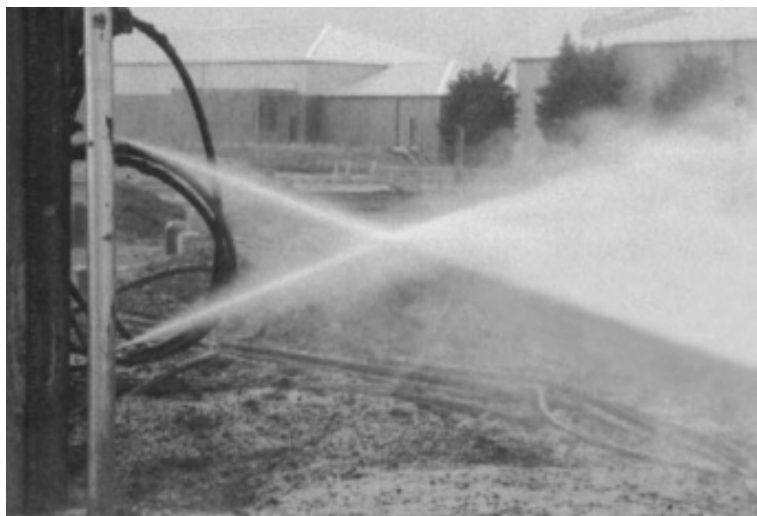
图5 X-Jetting 工法高压水射流试验 [19]
