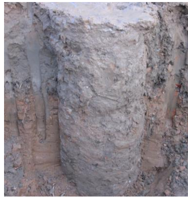
图8 足尺模型试验碳化搅拌桩开挖照
