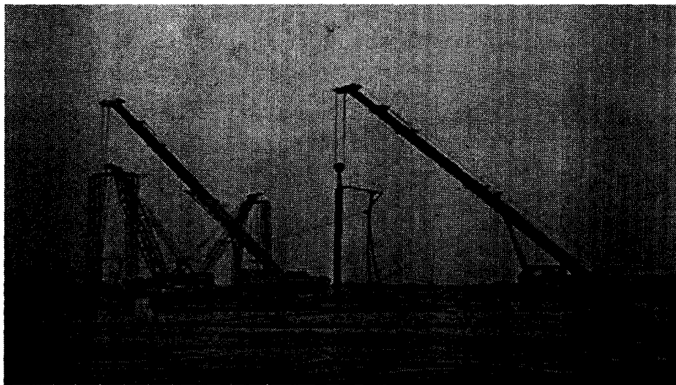
图14 大直径振冲碎石置换挤密桩复合强夯加固现场
