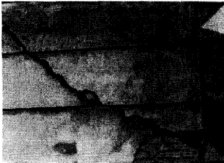
图 2 楼南侧 1-5 层代表性结构墙体严重开裂 破损、粉碎成块，裂缝内外透通，导致 窗框弯曲外观
