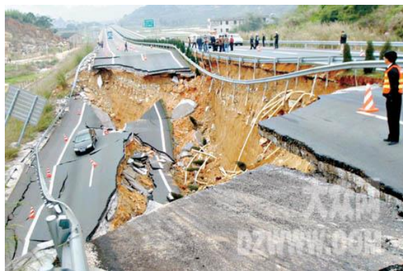
(a) CFG 加固地基路堤通车 2 年后滑移
