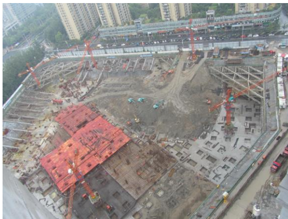
图 1 中心岛法施工实例
