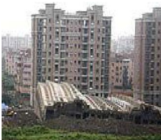
图3 上海某在建住宅楼突然倒塌
