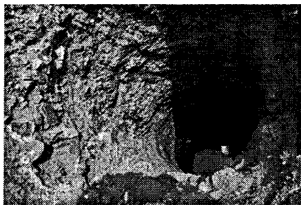
图 2-1 强风化泥质粉砂岩⑤中的成孔效果
